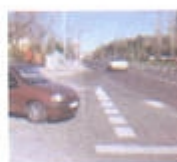
Marca transversal discontinua
