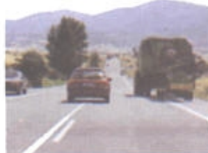
Marcas longitudinales continuas adosadas a discontinuas
