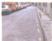
Marca amarilla longitudinal discontinua
